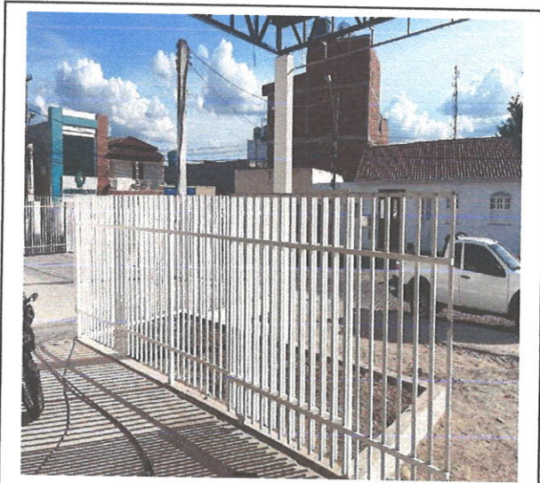
FOTO165: Pintura grade (Fachada)
