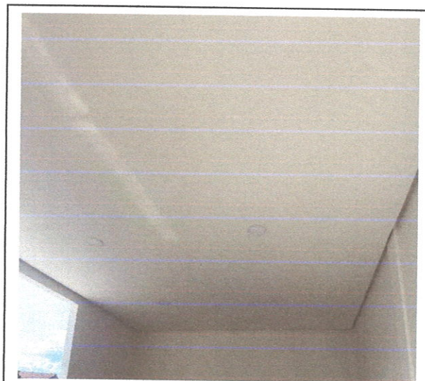
FOTO 158: Instalação forro e luminária
