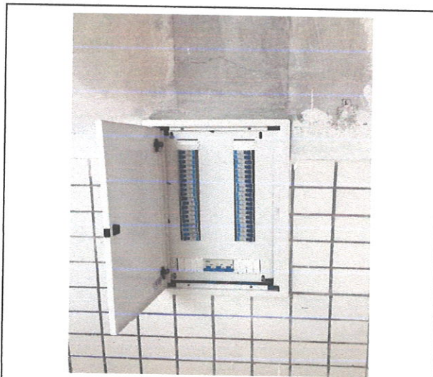
FOTO163: Instalação quadro elétrico
