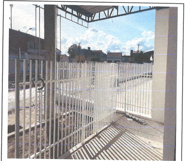
FOTO 166: Pintura grade (Fachada)
