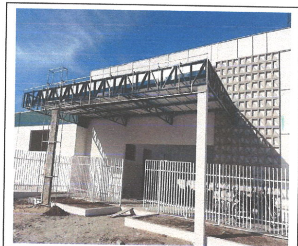
FOTO 164: Estrutura metálica marquise (Fachada)
